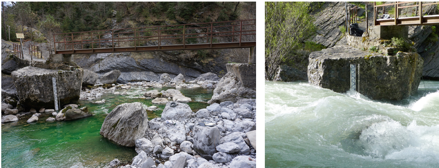
Figure 13: La station hydrométrique de la passerelle sur le río Irués est le point de suivi majeur de l'observatoire. Elle est au passage obligé des eaux souterraines dont les évolutions sont de précieux indices sur l'état de l'aquifère. Sur la vue de gauche le ruisseau en étiage s'écoule paisiblement lors d'un jaugeage par injection instantanée. A droite, de fortes pluies de mai se sont abattues sur le tardif manteau de neige, le débit dépasse à cet instant 17 m 3 /s (© JC Gayet).
