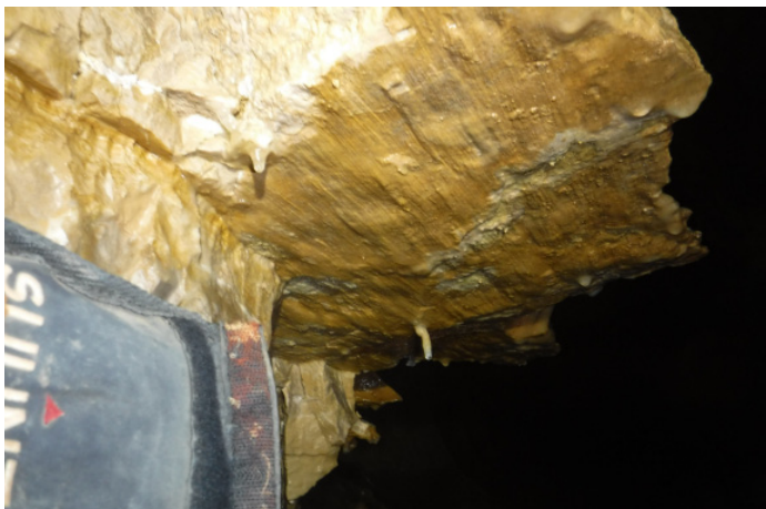
Stries de glissement horizontal d'une coulée gravitaire
