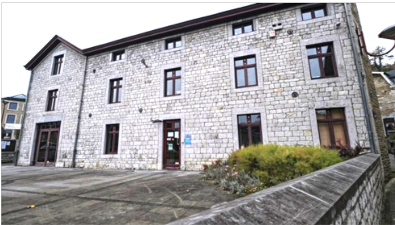
Façade de calcaire
